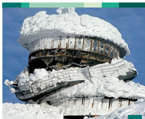
Ryc. 33. Przełamana i osunięta górna platforma Wysokogórskiego Obserwatorium Meteorologicznego IMGW na Śnieżce (źródło: www.polska.newsweek.pl ).
