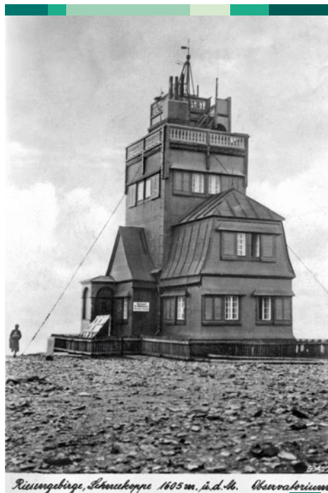
Ryc. 1. Budynek obserwatorium meteorologicznego na Śnieżce (1900–1974), rozebrany w 1989 roku.
